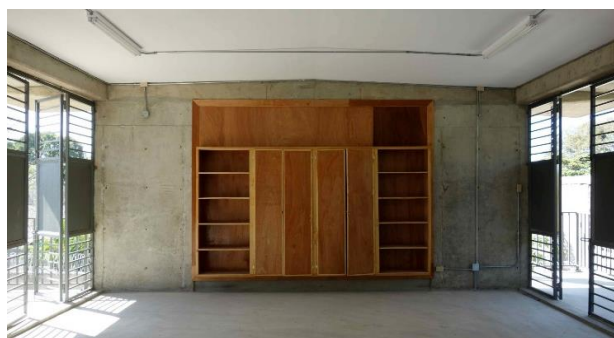
Armoires intégrées entre voiles (modèle BA)
