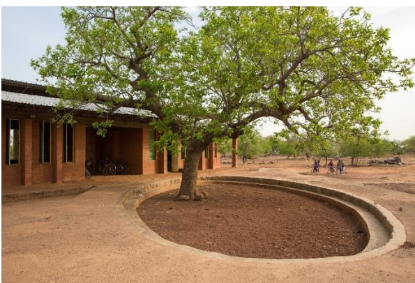
Ecole de Gando, Burkina Faso, arch. Francis Keré. (photo: D. Schwartz)
