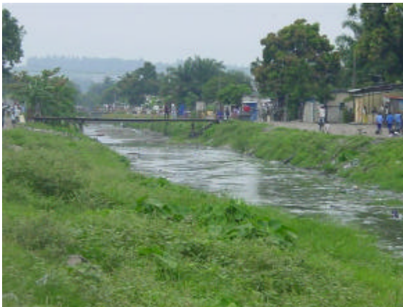
Curage d'un ruisseau pollué à Poto-Poto
