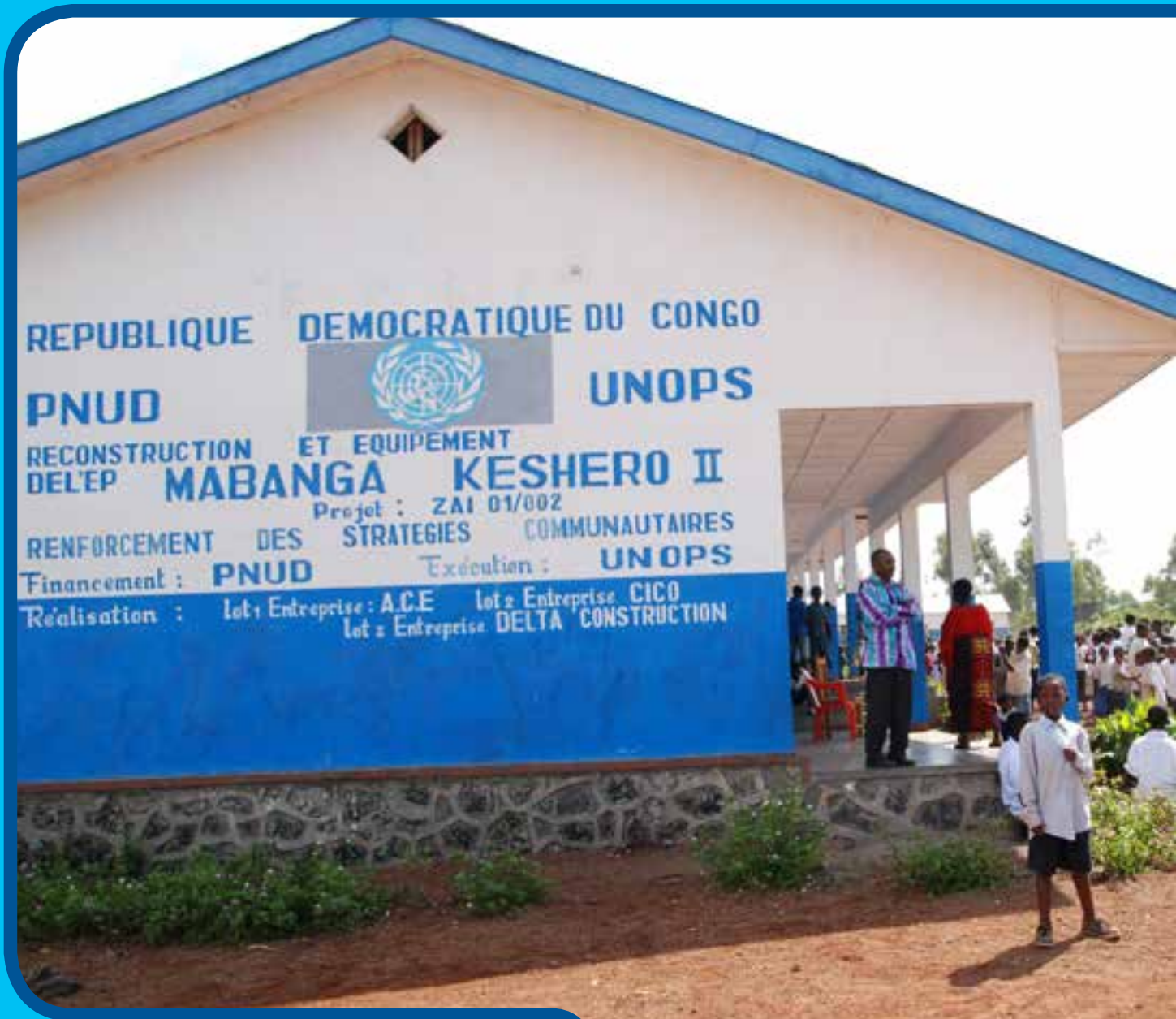
École primaire Mabanga reconstruite sur financement PNUD à Goma, Nord-Kivu. ©John Mwimba/PNUD 2007
