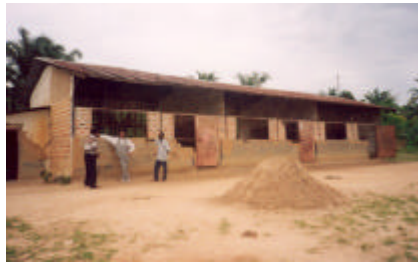
Ecole Primaire Wagenia (Province Orientale, avant réhabilitation)
