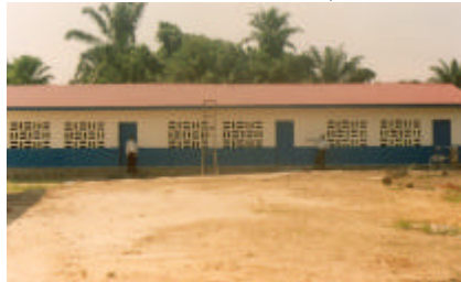
Ecole Primaire Wagenia (Province Orientale, après réhabilitation)
