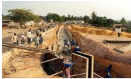
Construction des canalisations le long d'une route en cours de réhabilitation
