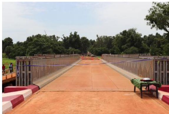
Photo 7 Nouveau pont de Bamingui sur la route de NDELE
