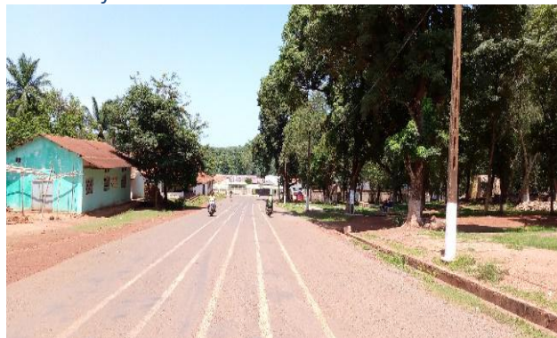
Photo 8 infrastructure routière de la ville de Bambari
