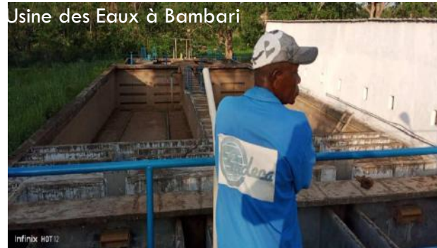
Photo 13 Usine des eaux de SODECA à Bambari
