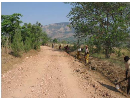
Piste d'accès au barrage réhabilité de Rutana-Sept 2006
