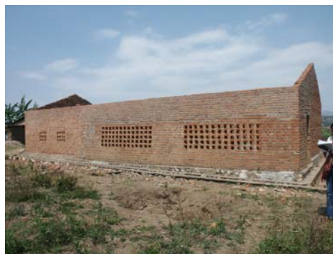
Centre semencier en construction à Gasaka/ Makamba-Sept 2006
